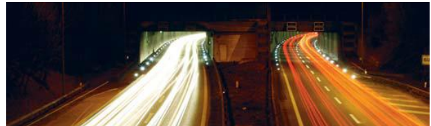
Abb. 2 Portal des Gubristtunnels, in dem wiederholt Tunnelmessungen 2 durchgeführt wurden
